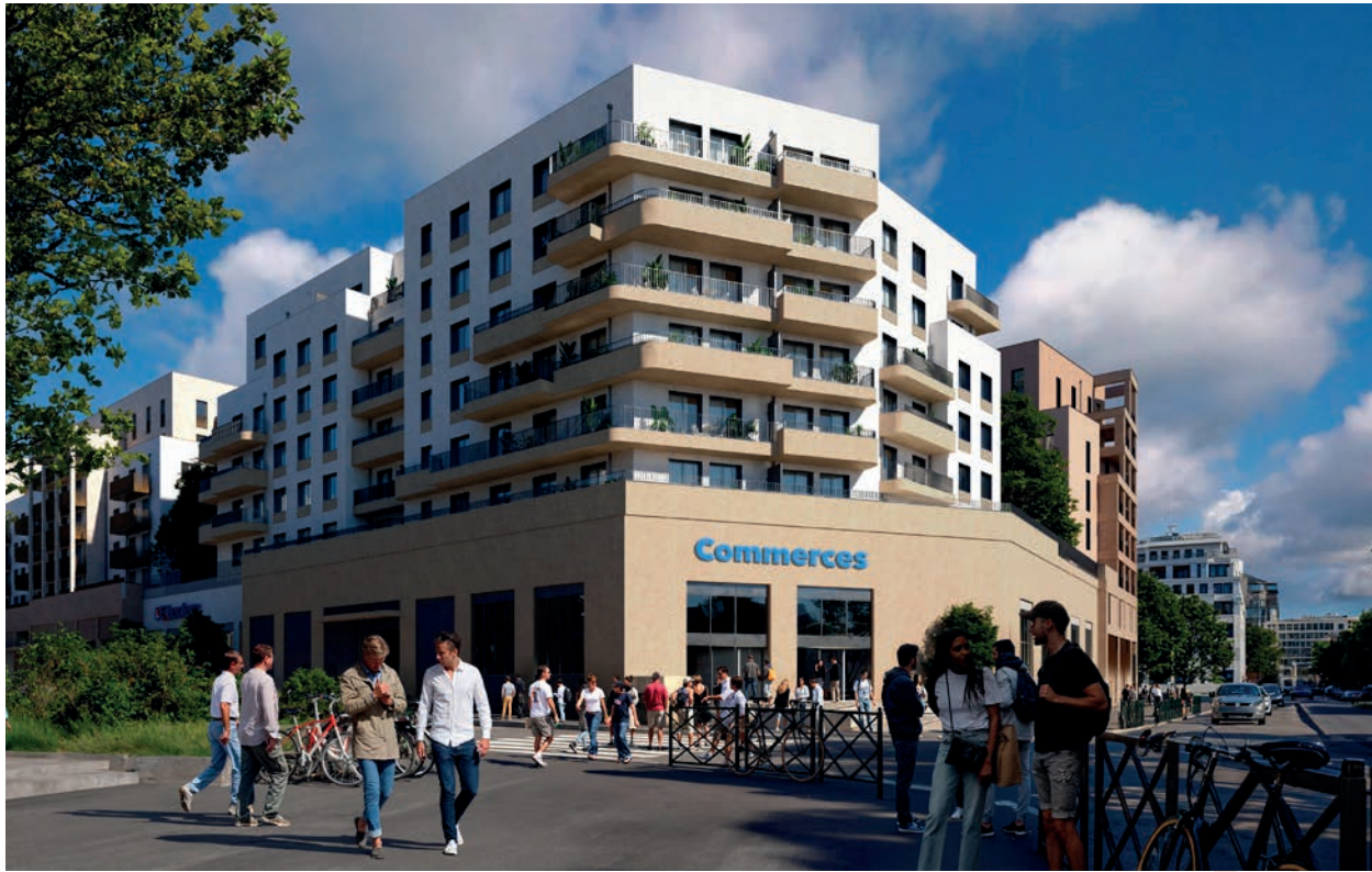
Vue de l'Hypermarché en rez-de-chaussée
